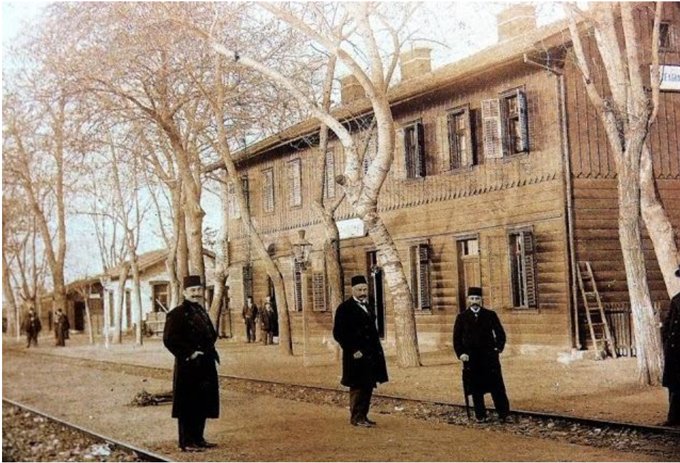
Δεδέαγατς (Αλεξανδρούπολη). Το κτίριο του λεγόμενου Γαλλικού σιδηροδρομικού σταθμού, το οποίο σώζεται έως σήμερα
